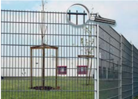
Eckausbildung Gitterzaun UNI mit Sicherungs-U; Gitter oben 15 mm überstehend
