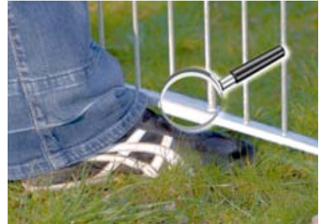
Detail Gitterzaun UNI mit Verletzungsschutz: Vermeidung von Unfällen durch einen glatten oberen und wahlweise unteren Abschluss
